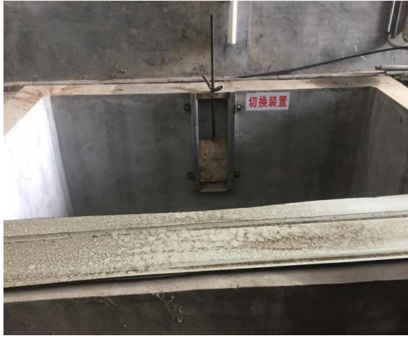
图 2-2 事故应急池及应急切换装置
