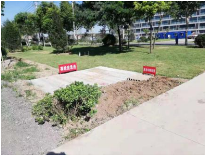
图 2-2 事故应急池、应急切换阀门
