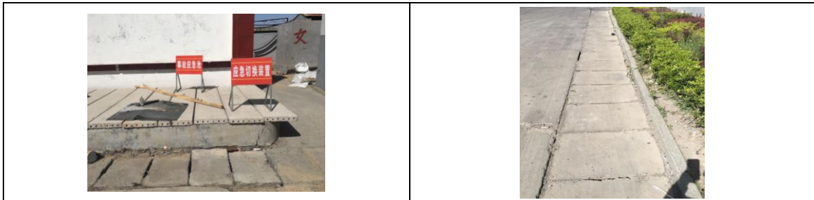
图 9-1 事故应急池及雨水管道
