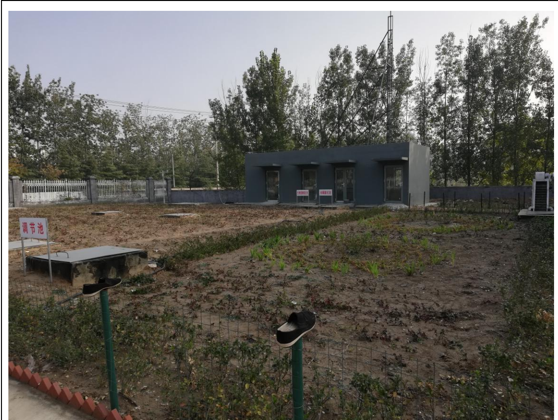
图 4-6 医院污水处理站
