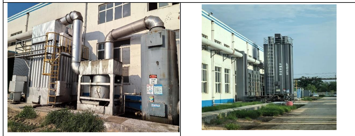
高压静电捕油装置
