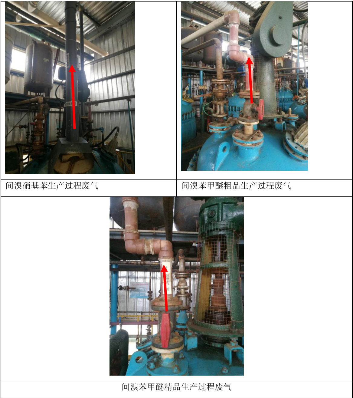
图 3-1 车间废气收集管道走向
